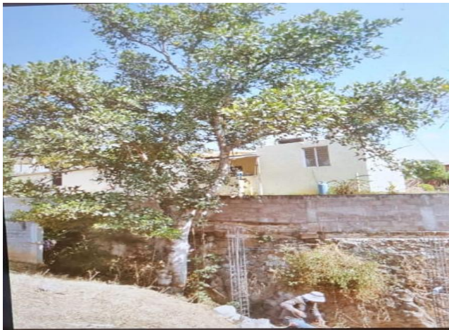
DERRIBO DE ARBOLES
