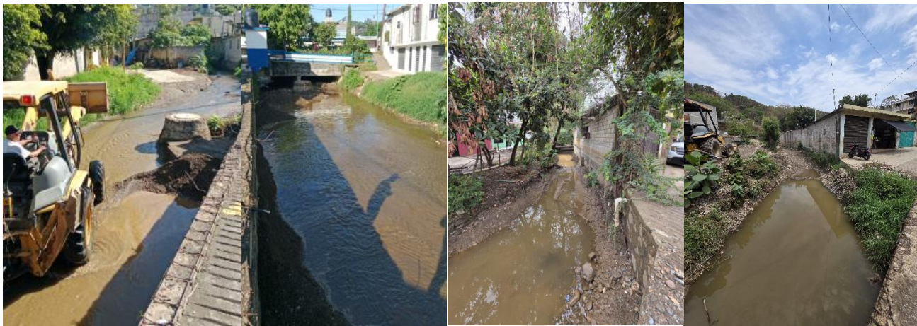
DESAZOLVES DE RÍOS, CALLES/CAMINOS Y CUNETAS
