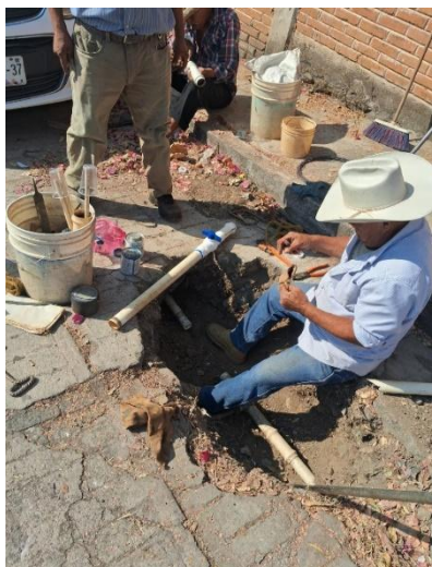
Reparación de fugas
