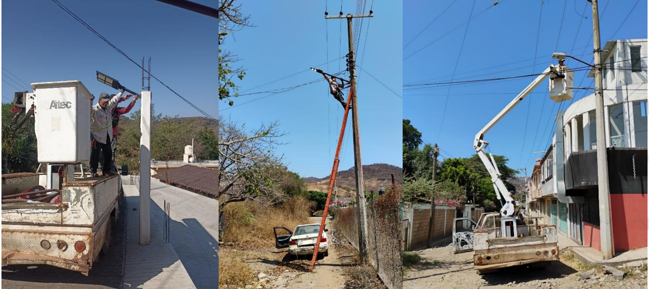
Sustitución de las luminarias
