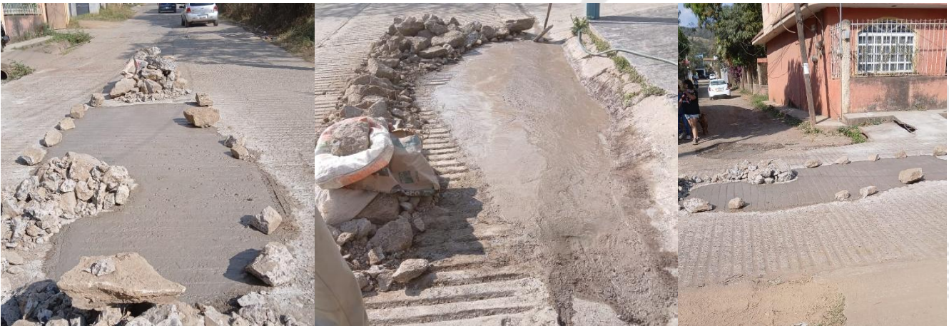
BACHEO CON CONCRETO HIDRÁULICO
