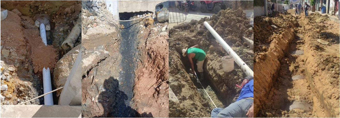
REPARACIÓN DE DRENAJES
