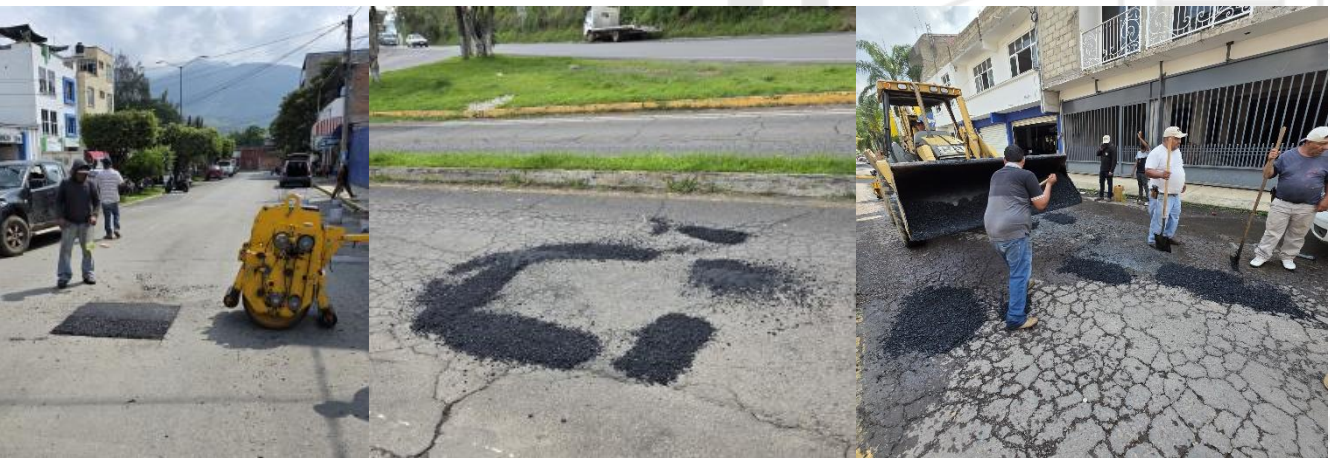
BACHEO CON MEZCLA ASFALTICA
