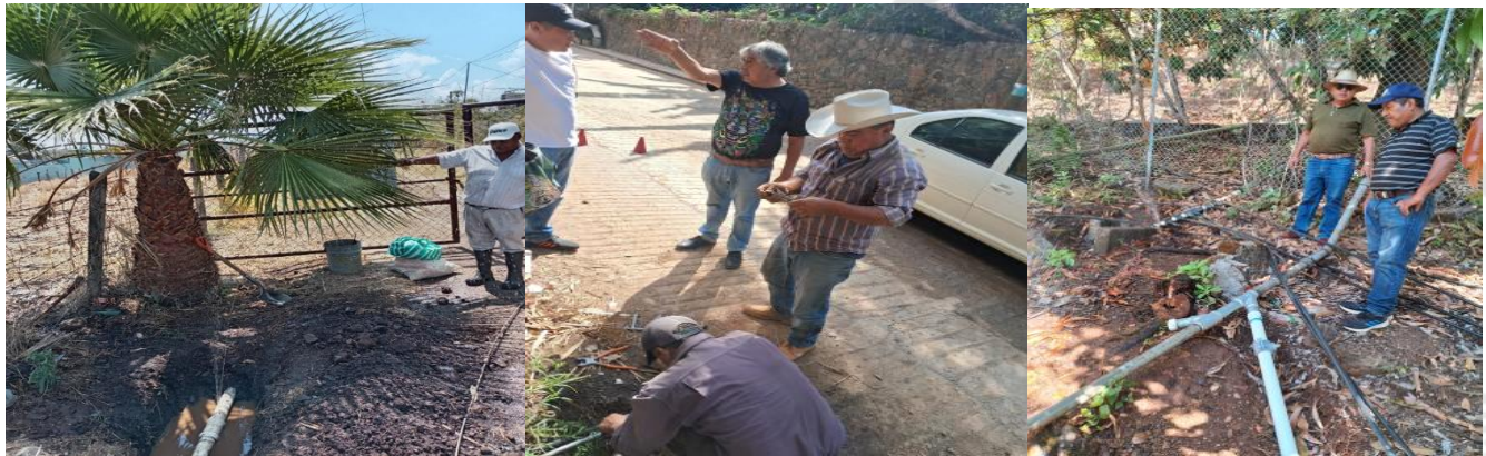
Verificación de la línea
