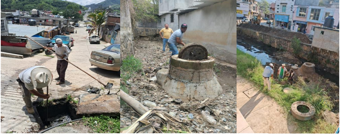
Desazolve de drenaje
