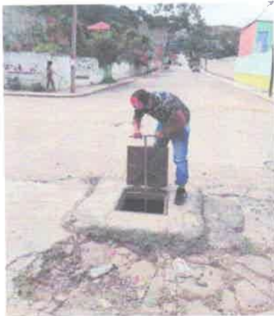
Válvulas de aislamiento, corte o sectorización
