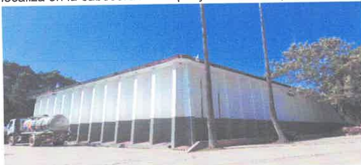
Tanque de almacenamiento para agua, en la cabecera Municipal y tiene una capacidad de 10,000 m 3
