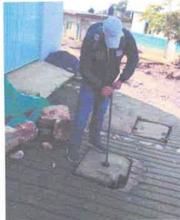
Válvulas de aislamiento, corte o sectorización
