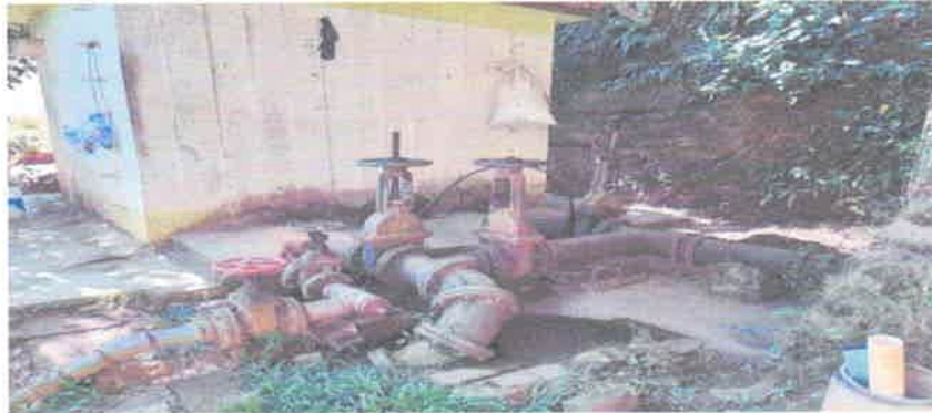
Válvulas de control de presión y flujo y/o reguladoras de presión
